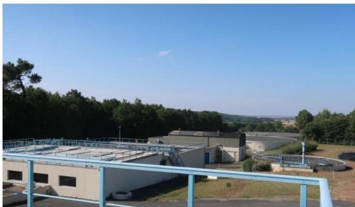
L'usine des Coulées du SEVT à Taizé-Maulais est gravitaire : l'eau arrive sur les hauteurs, et redescend d'étape en étape grâce à la gravité. À une exception : la phase de décarbonatation, qui nécessite de faire remonter l'eau un étage plus haut.
