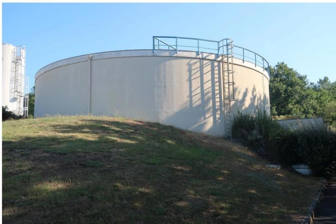
Ce bâtiment concentre l'eau qui arrive des différents forages. C'est le point d'entrée dans l'usine, avant le début des processus de purification.
